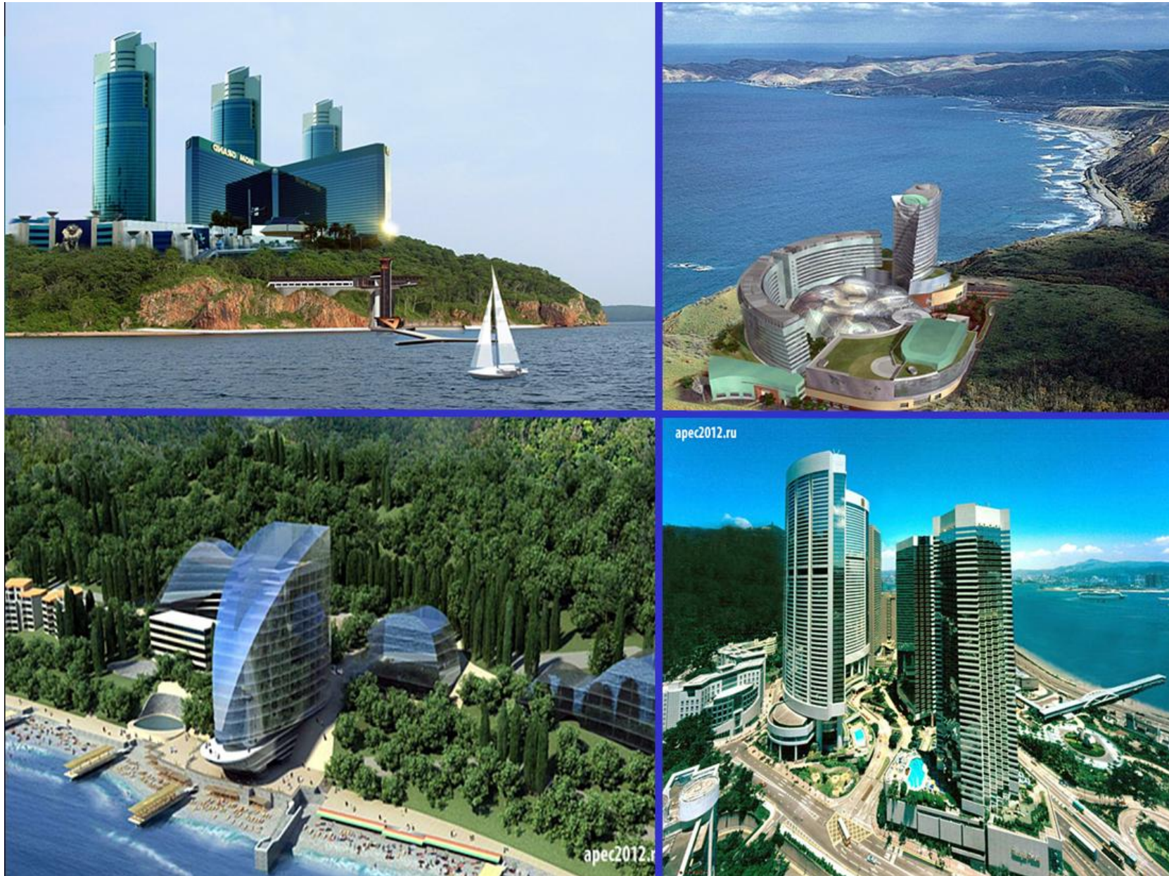
Рис. 8. Строящийся гостиничный комплекс во Владивостоке
