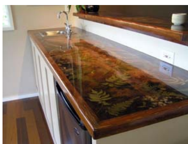
Рис. 1. Столешница, выполненная методом заливки декоративных элементов [4]
