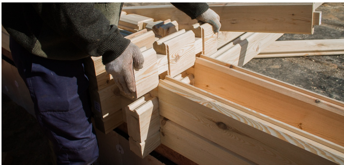
Рис. 1. Конструкция двойных стен с перерубами
